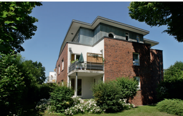
Foto: INDUSTRIA; Objekt: Ahrensburg
